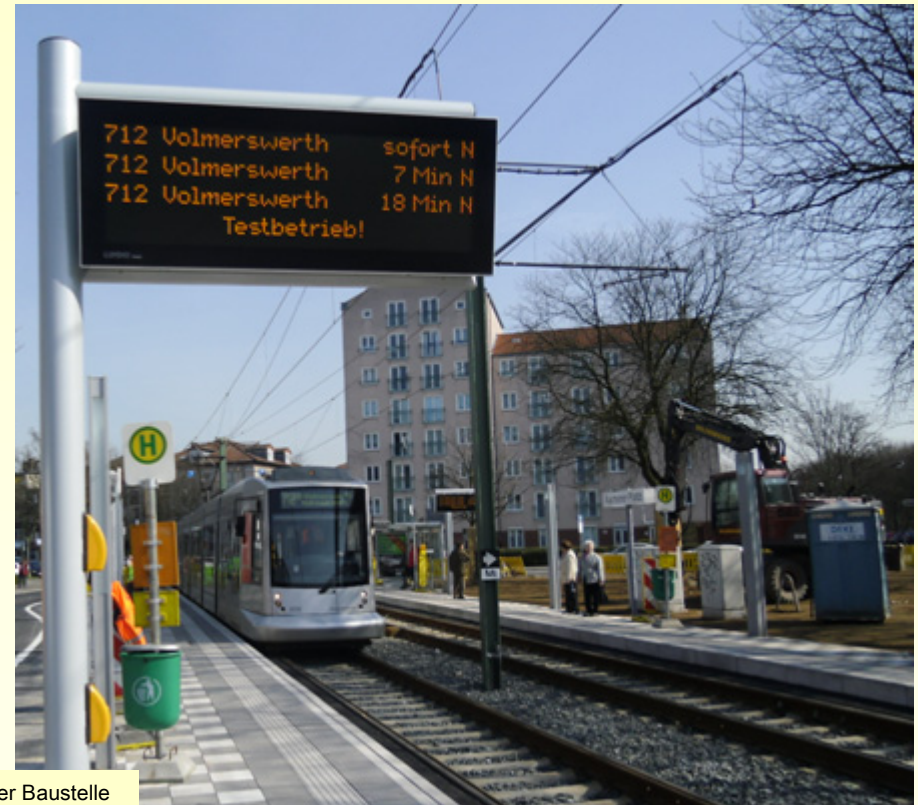
Bilder von der Baustelle
