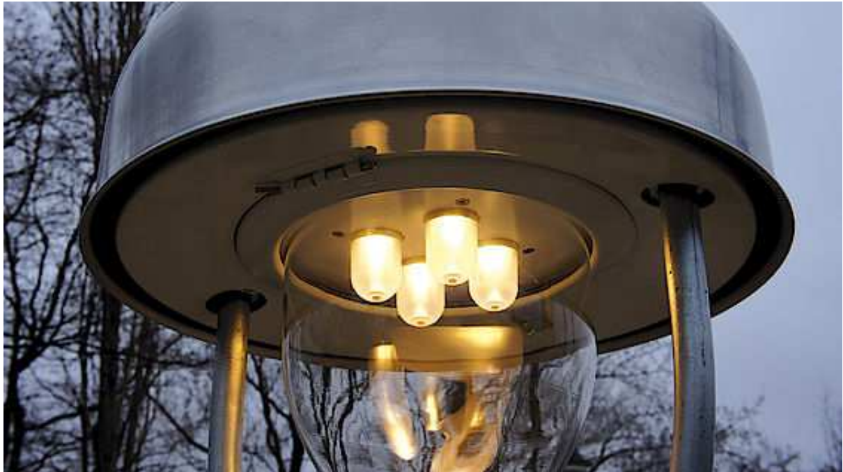
Auf LED-Leuchtmittel umgerüstete Gaslichtleuchte
